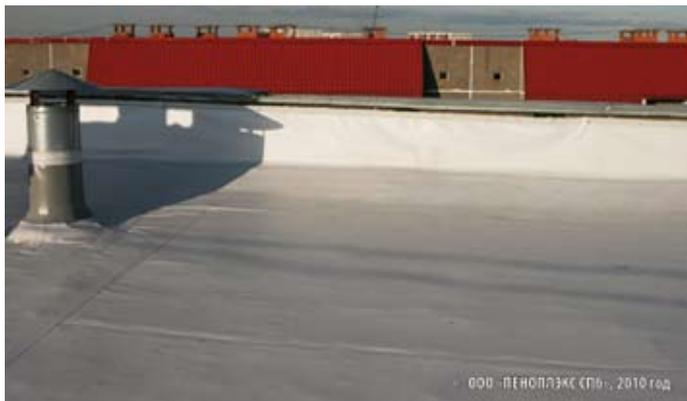
Фото 1. Реконструкция старой битумной кровли без доутепления, г. Гатчина Ленинградской обл. Материал ПЛАСТФОИЛ®
