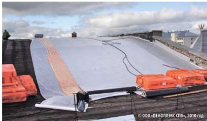
Фото 2. Реконструкция старой битумной кровли с доутеплением, г. Нарьян-Мар. Материалы ПЛАСТФОИЛ®, ПЕНОПЛЭКС®
